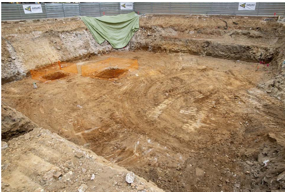
Vista general del solar un cop finalitzats els rebaixos de terres
